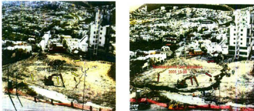
Fotografía 9. Deslizamiento rotacional en la colonia San Jerónimo en 2005.
