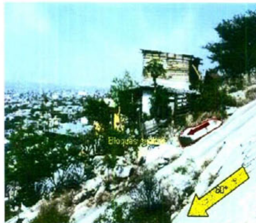
Fotografía 10. Deslizamiento capa a capa o planar.
