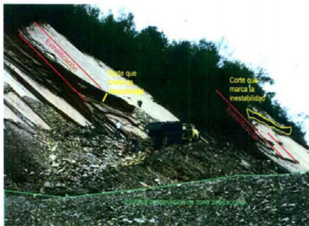
Fotografía 5. Inestabilidad de una ladera: tanto la inclinación de la ladera como la de la discontinuidad son paralelas; los cortes que se han efectuado aceleran el deslizamiento por falla plana de los estratos.
